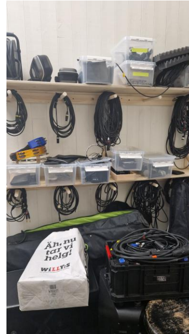
Upphängning av kablar mm.
